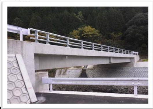
井手口橋(左岸側から)
