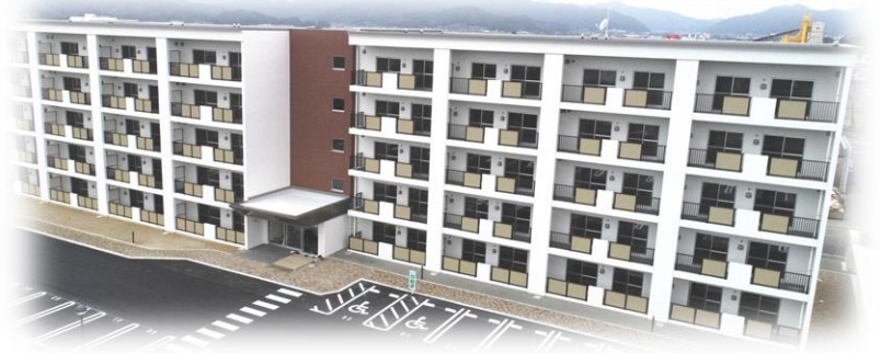
完成した中村住宅
