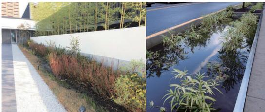
敷地に降る雨水を浸透・一時貯留・遅延させるとともに、水の流れを可視化させる「あめにわ」の事例
