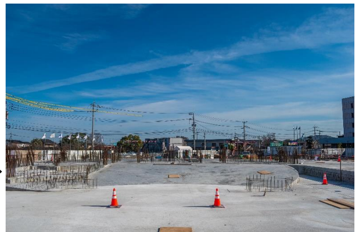
床コンクリート作業の完了の様子→
