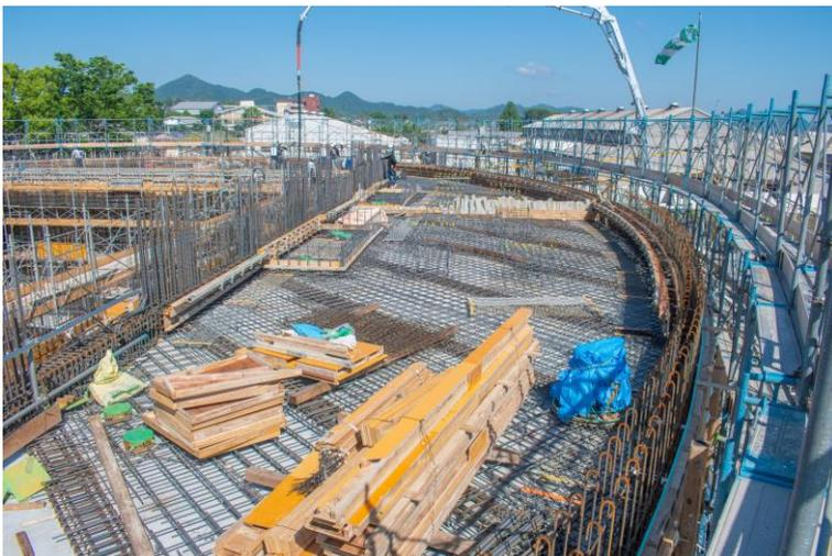
3階屋根で鉄筋を組み立てている状況。
