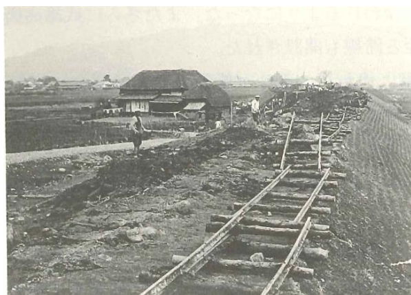
写真：建設中の長崎本線
