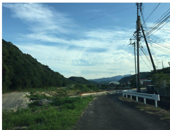
写真 景観に配慮されていないガードレール
