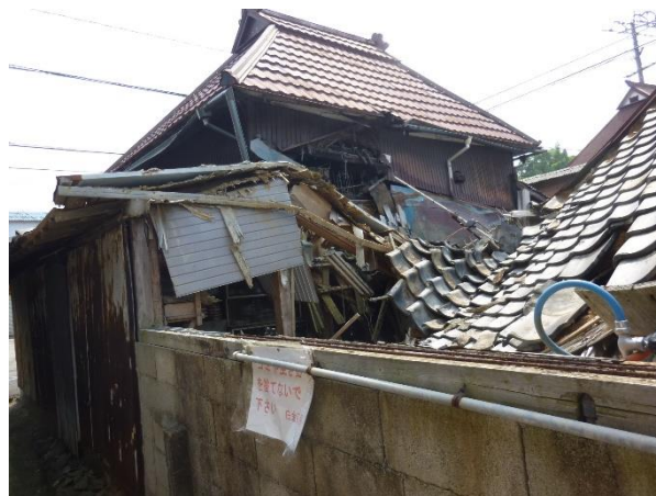
写真 荒廃が進行する空き家
