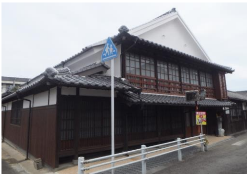
伝建事業を利用した建物の修理状況
