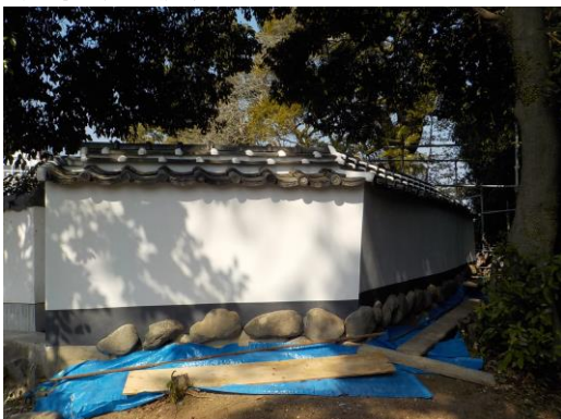
鹿島城赤門続塀保存修理(修理中)
