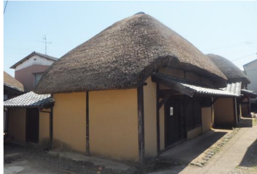
伝建事業を利用した建物の修理状況
