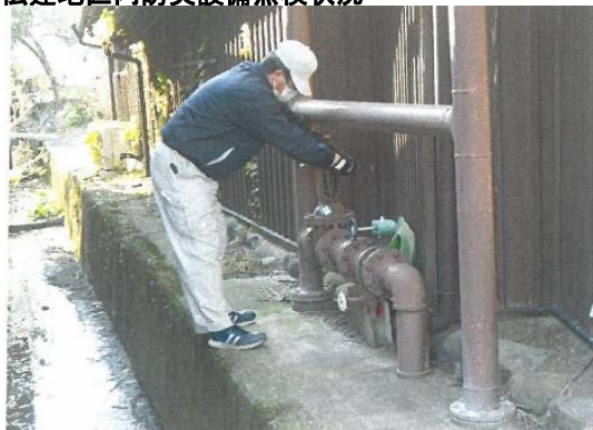
伝建地区内防災設備点検状況
