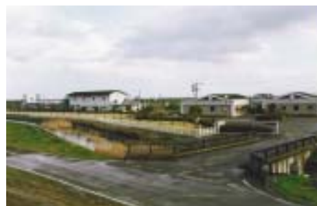
○浄化センター(終末処理場)
