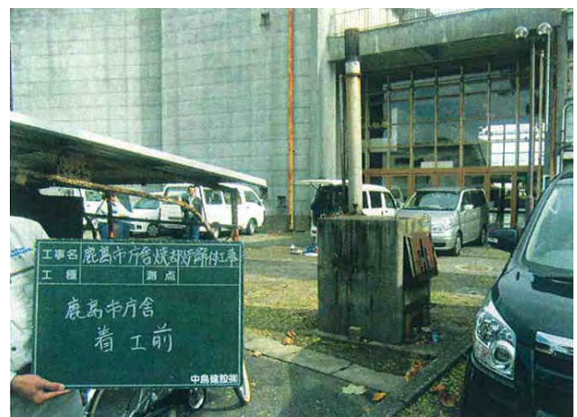
焼却炉解体撤去事業
