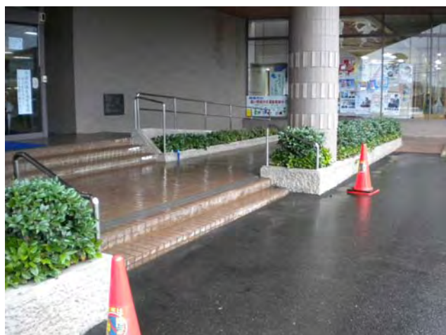
スロープ手すり設置事業
