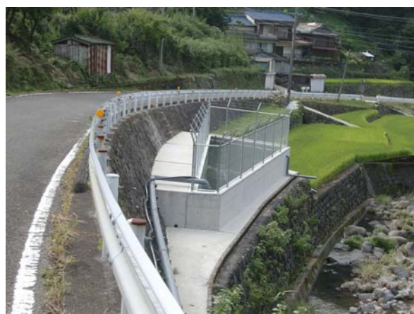
防火水槽新設工事
