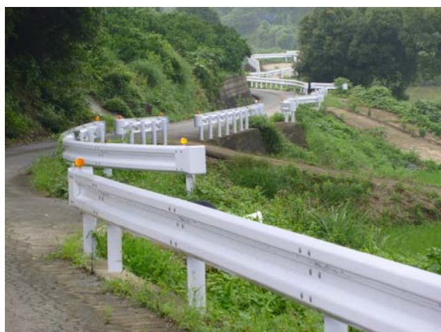
○市道本谷線交通安全施設整備工事(嘉瀬浦区)
