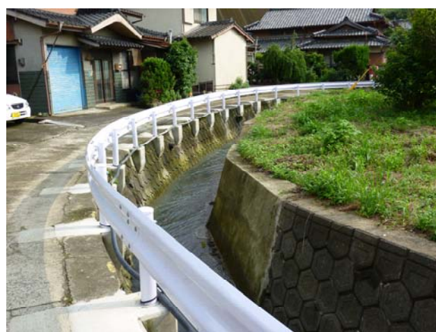
○市道大宮田尾3号線交通安全施設整備工事
