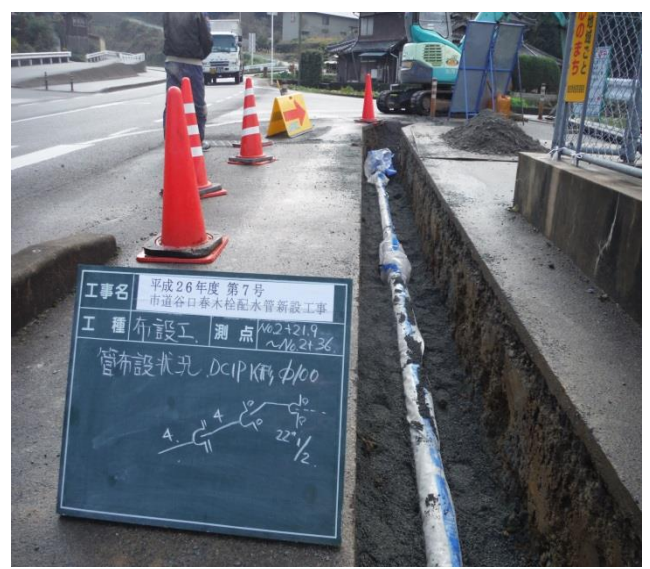
配水管新設工事(谷口春木線)
