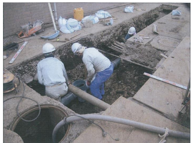
庁舎排水設備改修工事(庁舎裏)
