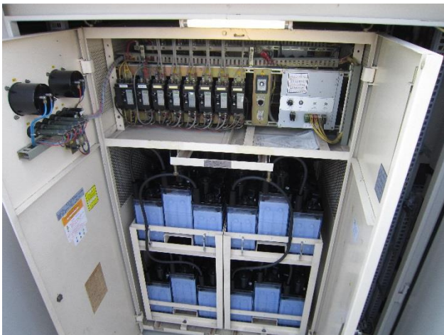
庁舎非常用蓄電池(2階キュービクル)
