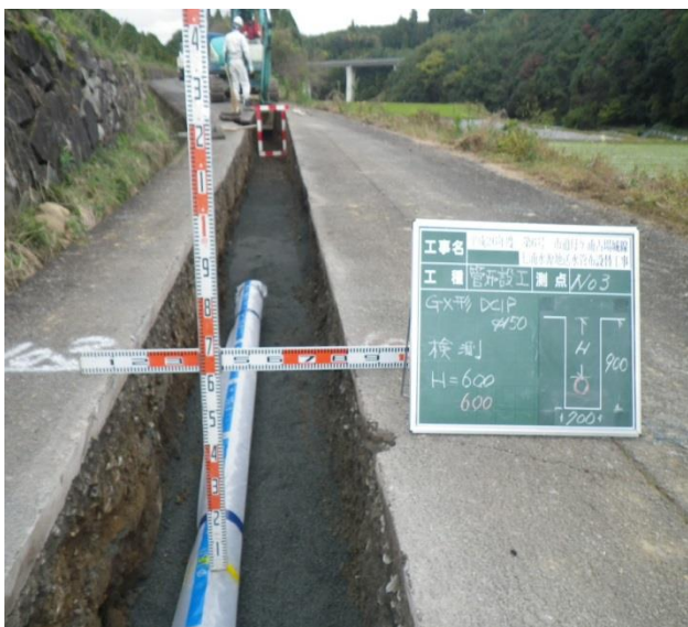
送水管布設替工事(母ヶ浦古場城線)
