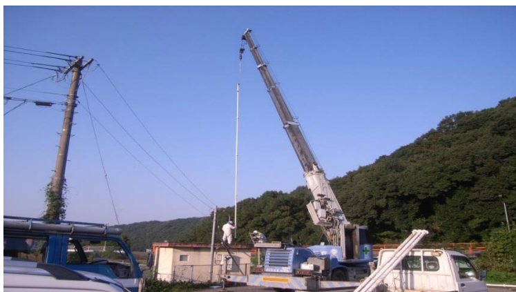
取水ポンプ取替工事(下古枝水源池)
