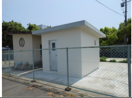
大村方第2水源地(ポンプ室)
