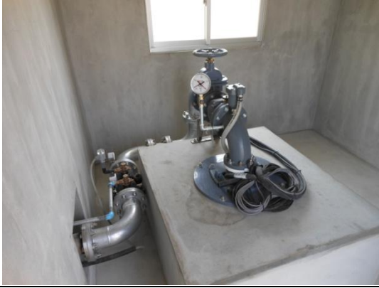
○大村方第2水源地(取水ポンプ)
