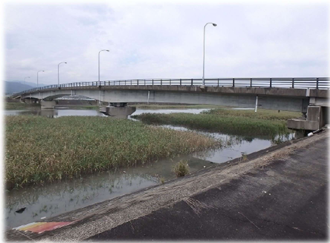
鹿島大橋 1987年架設
