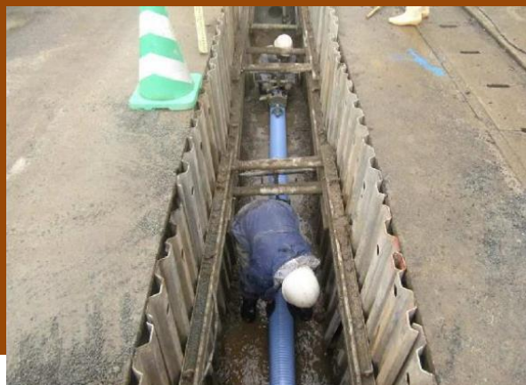
▲污水管渠築造工事の様子
