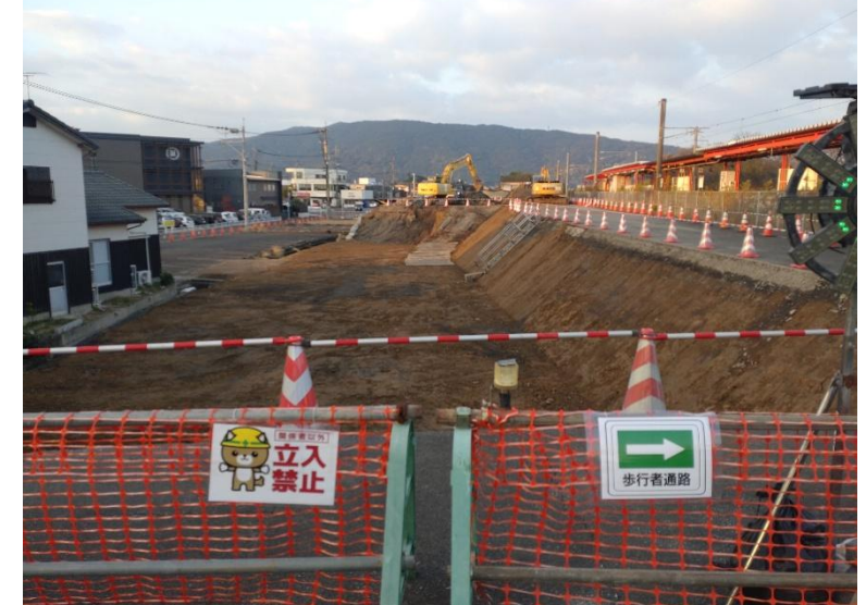
R7.11現在の工事現場
