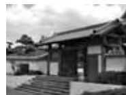
☒北鹿島小学校 (旧常広城)の校門
