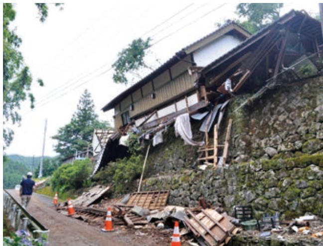
令和2年7月 土砂崩れによる家屋倒壊
