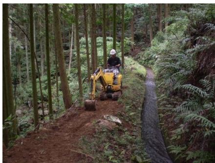
28.9.1~30 水路(シード) 管理道補修 鮎越
