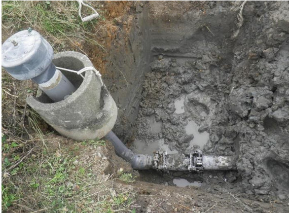
世間 パイプライン漏水補修 H29.6.10
