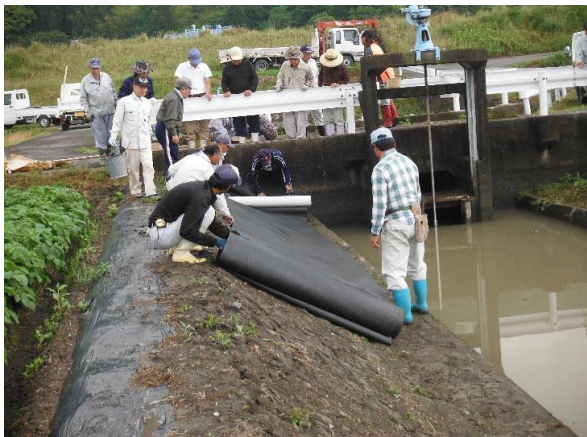
森区 草防シート設置 H29.5.12
