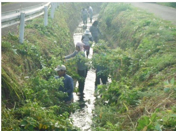
幹線水路 水路の草刈り・泥上げ H29.9.10
