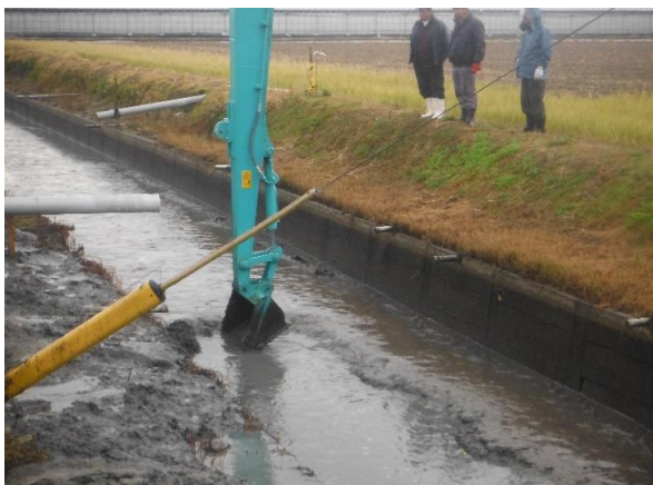
常広区 水路の浚渫 H29.12.9
