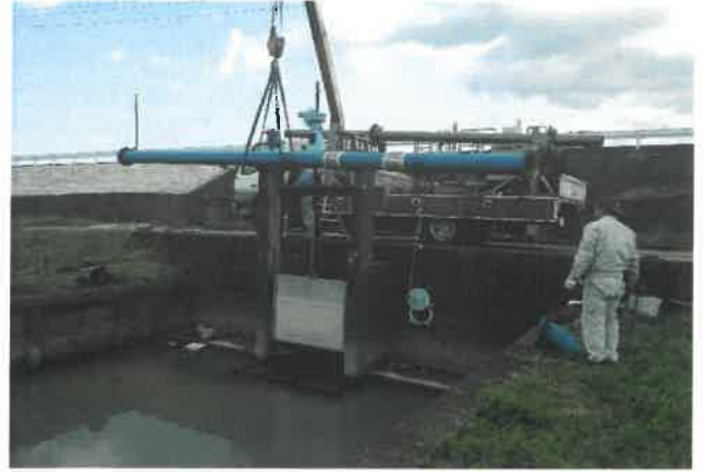
重ノ木 水管橋取り替え H31.3.23
