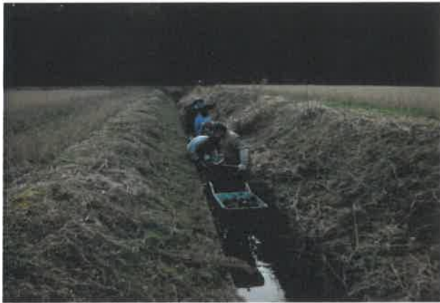
大宮田尾 水路の泥上げ H31.2.17
