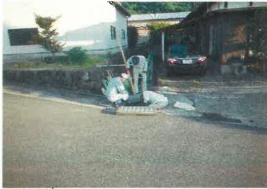
若殿分 水路の泥上げ H30.4.29
