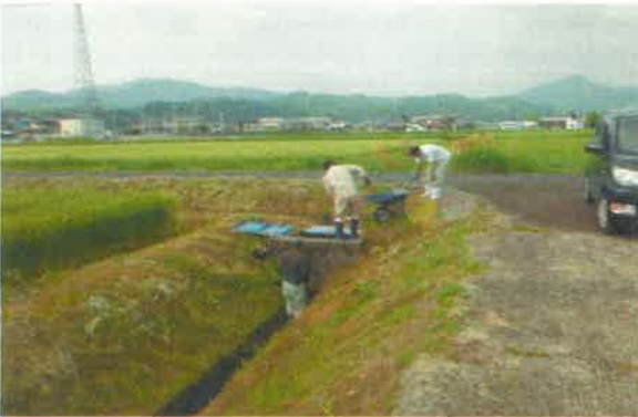
若殿分 農道側溝の泥上げ H30.4.29
