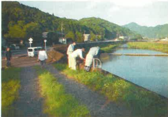
若殿分 施設の機能診断 H30.6.17
