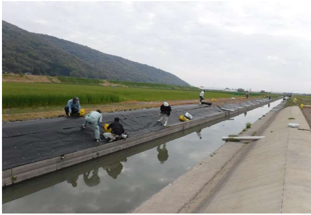
森区 防草シート設置 H31.4.14
