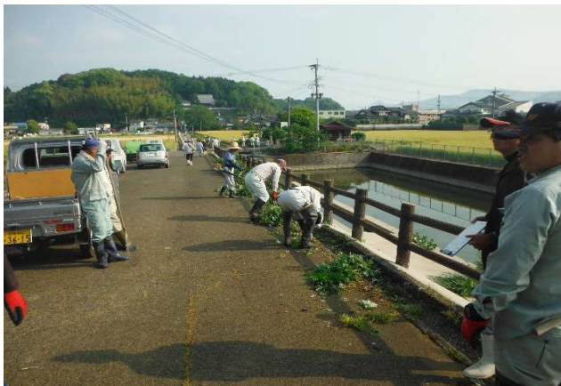
幹線水路 水路の草刈り・泥上げ R1.5.12
