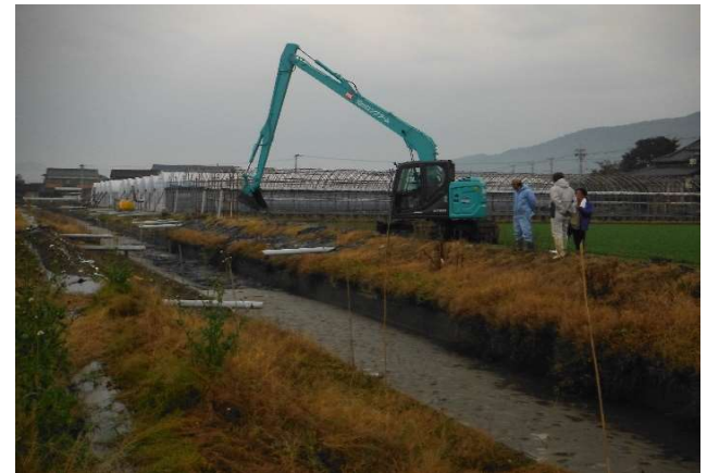
常広区 水路の泥上げ R1.12.25
