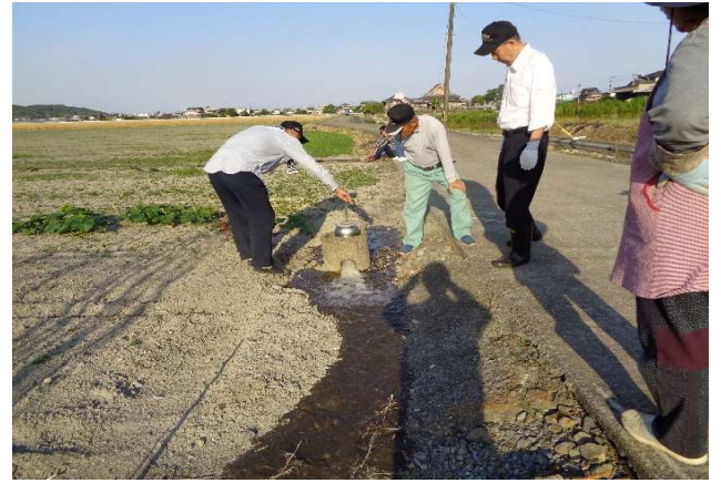
土井丸区 施設の点検・機能診断 R1.5.23
