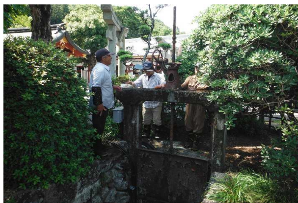
下古枝 施設の点検・機能診断 R2.6.7
