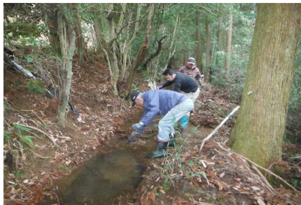
鮎越 水路の泥上げ R3.2.28
