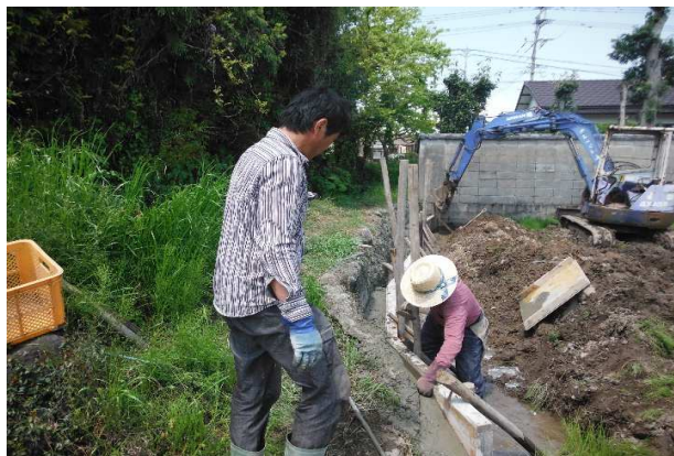
大村方 破損施設の補修 R2.4.27
