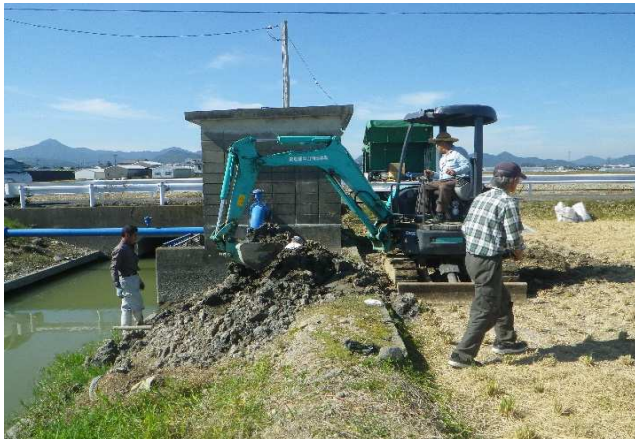
重ノ木 送水管漏水補修 R2.10.26
