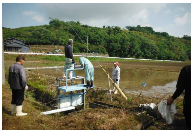
大宮田尾 施設の点検・機能診断 R2.5.17
