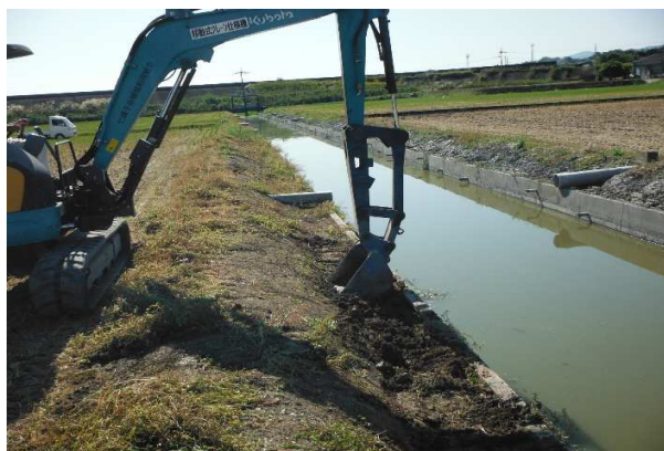
七浦干拓 水路陥没補修 R2.10.15
