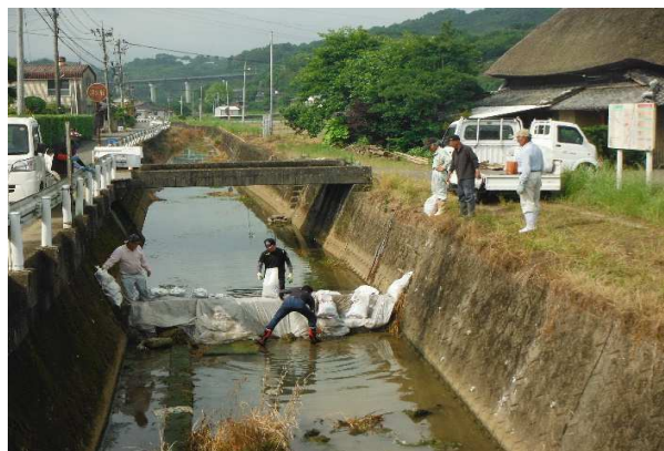
西葉 水路附帯施設の保守管理 R2.6.7
