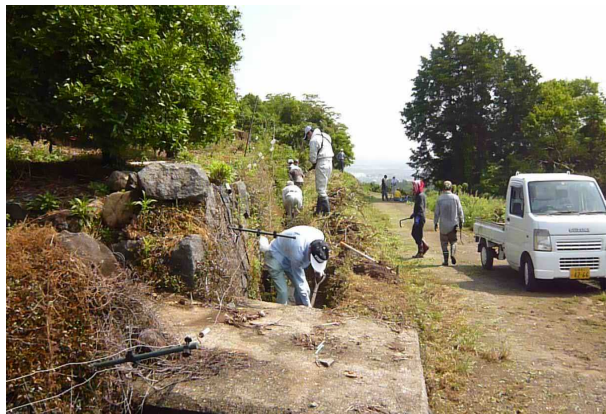
大殿分 水路の泥上げ R2.5.10
