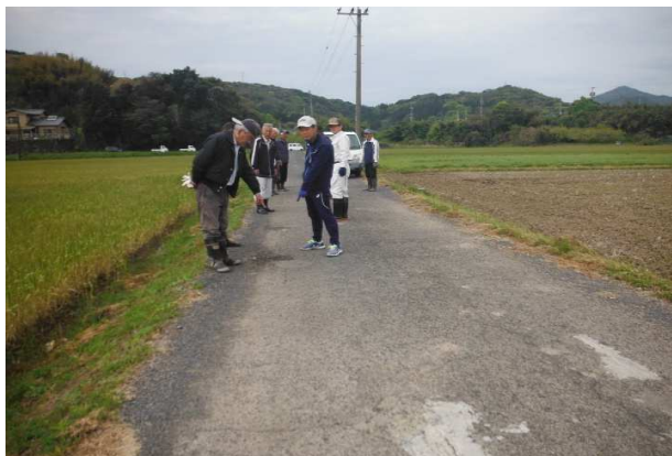
伏原 施設の点検・機能診断 R2.4.19
