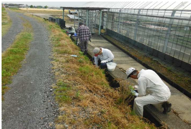
南川 水路目地詰め R2.5.10
