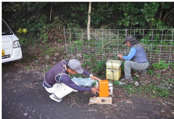
伏原 鳥獣害防護柵の補修 R2.9.15
