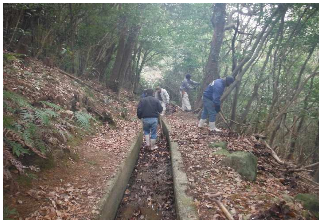
新方 水路の泥上げ R4.2.23
