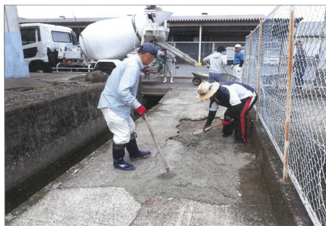
浜新町 破損施設の補修 R3.5.1
