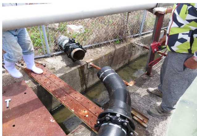
浜干拓 送水管補修 R3.7.21
