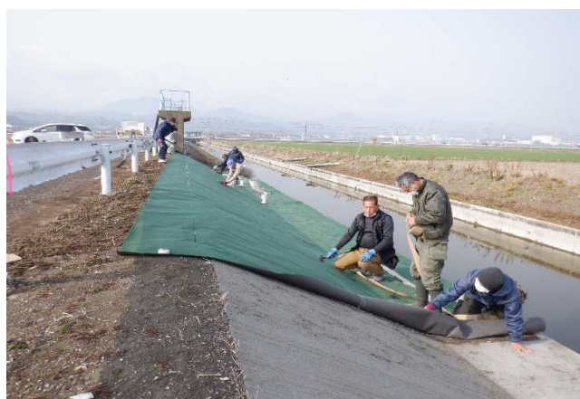
浜東部 防草シート設置 R4.3.5
