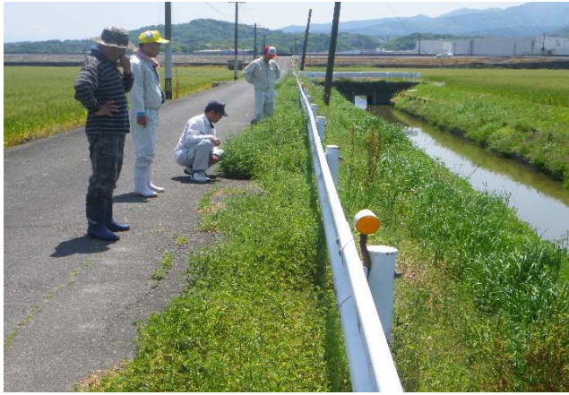
重ノ木 施設の点検・機能診断 R3.4.25
