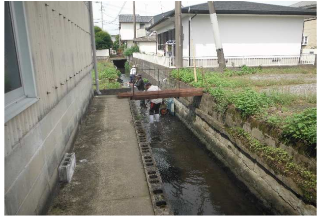
小舟津 水路の泥上げ R3.6.6
