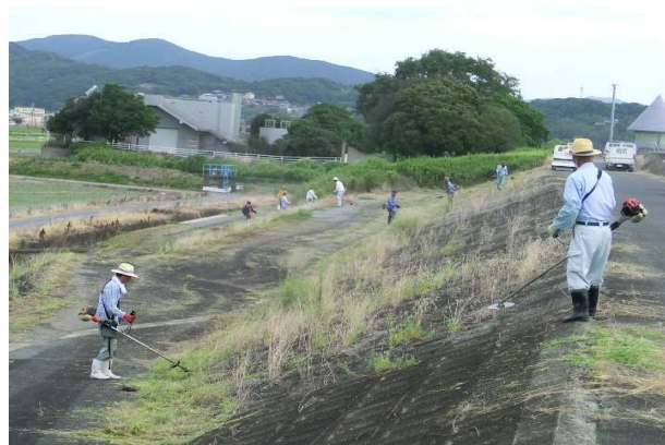
全体 堤防草刈り作業 R3.7.25
