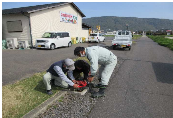
中村区 施設の点検・機能診断 R3.4.9
