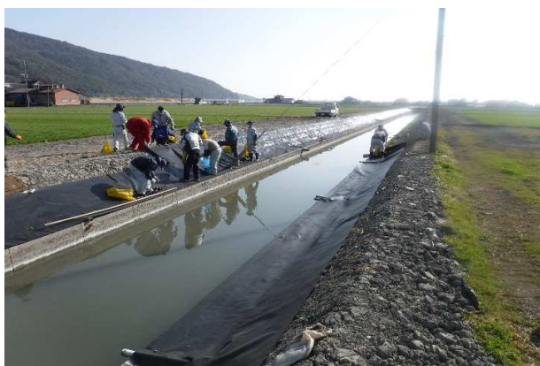
森区 防草シート設置 R4.2.27
