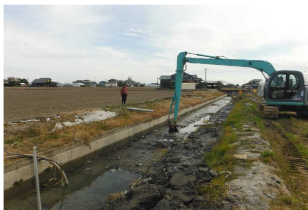
常広区 水路の泥上げ R3.11.30
