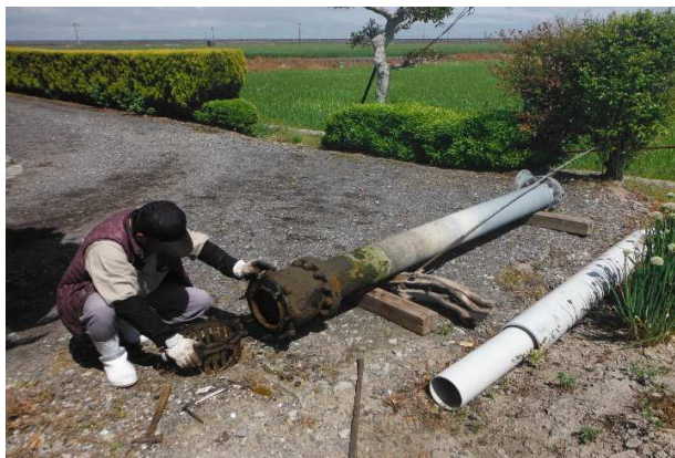
新籠区 ポンプ給水管補修 R3.4.14
