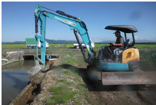
七浦干拓 水路陥没補修 R3.9.9
