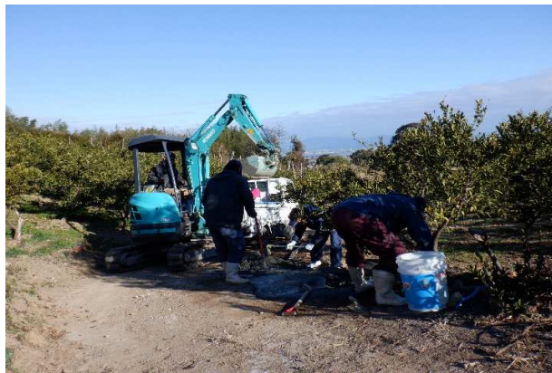
西葉 破損施設の補修 R4.1.21
