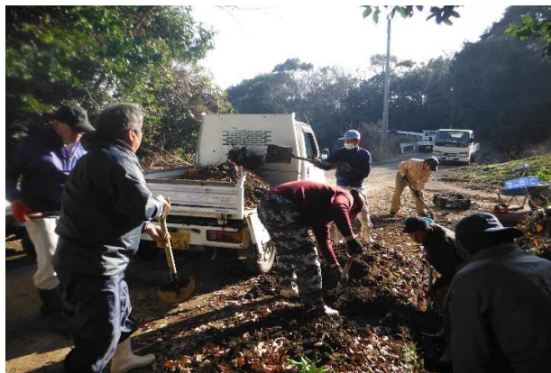
飯田 水路の泥上げ R4.2.27
