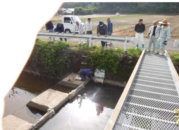
音成 施設の点検・機能診断 R3.5.9
