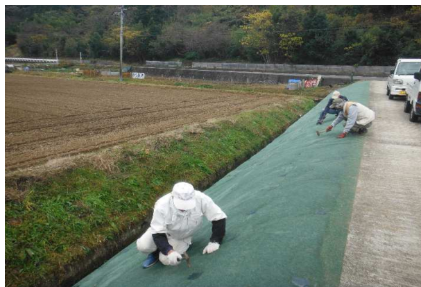
南川 防草シート設置 R3.11.28
