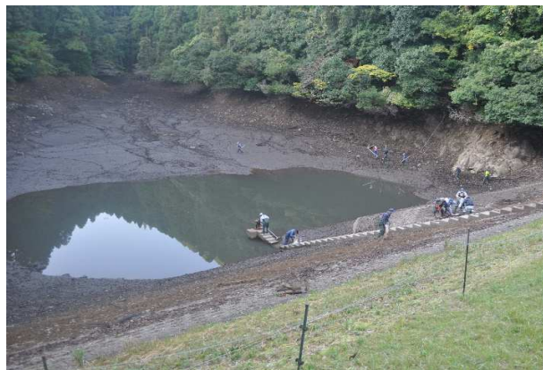
下浅浦 ため池ゲートの保守管理 R3.11.7
