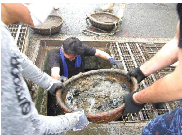
庄金区 水路 泥上げ R4.6.5
