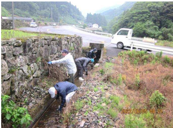
新方区 水路 泥上げ R4.6.5
