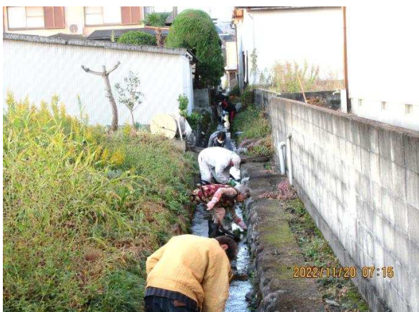
八宿区 水路 泥上げ R4.11.20
