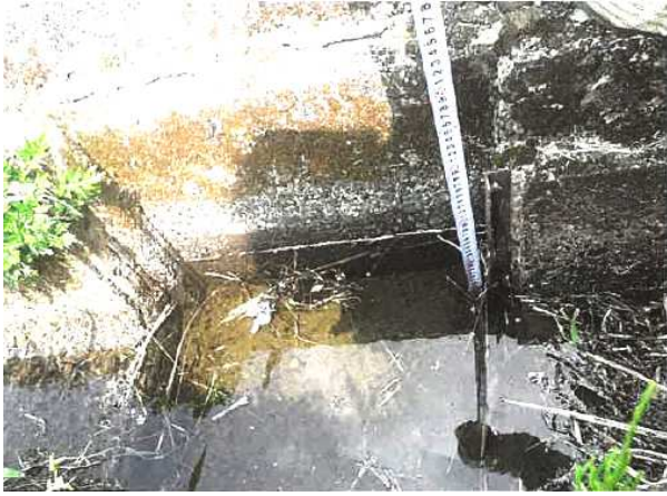
若殿分区 施設の点検・機能診断 R4.4.3
