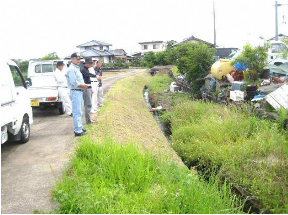
若殿分区 点検・機能診断
