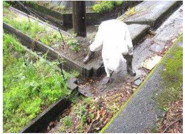
若殿分区 水路 泥上げ
