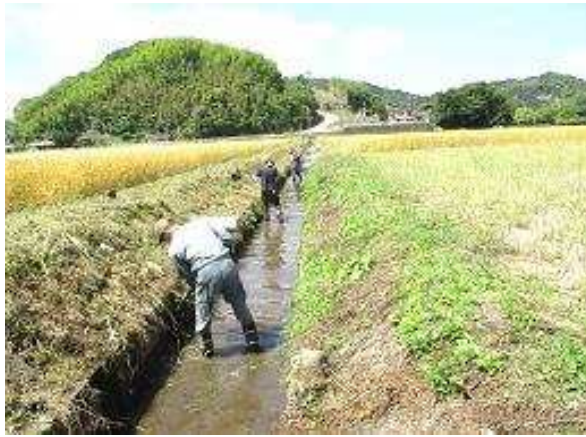
伏原区 水路 泥上げ
