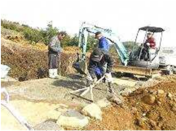
鮎越区 破損施設の補修
