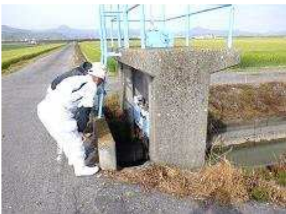
浜干拓地区 点検・機能診断
