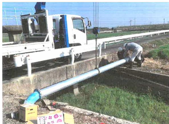
浜東部地区 送水管修理
