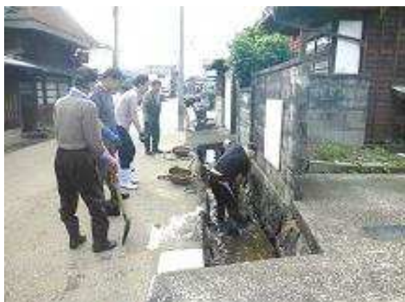
庄金区 水路 泥上げ
