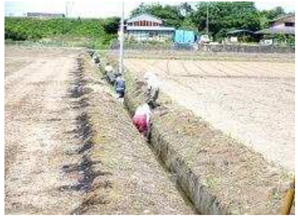
龍宿浦区 水路 泥上げ
