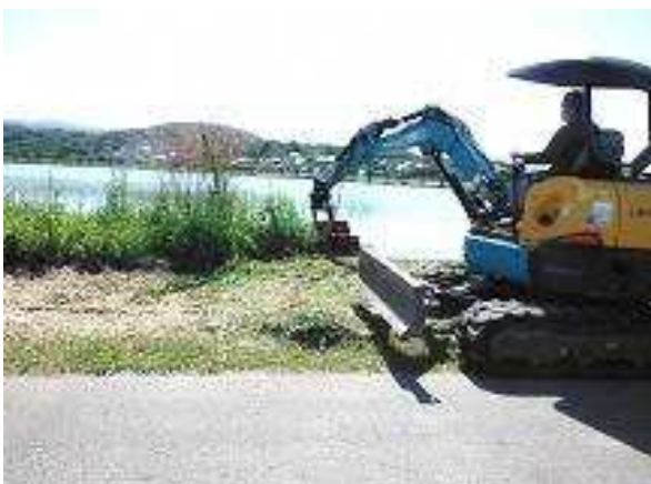
七浦干拓地区 ため池 草刈り
