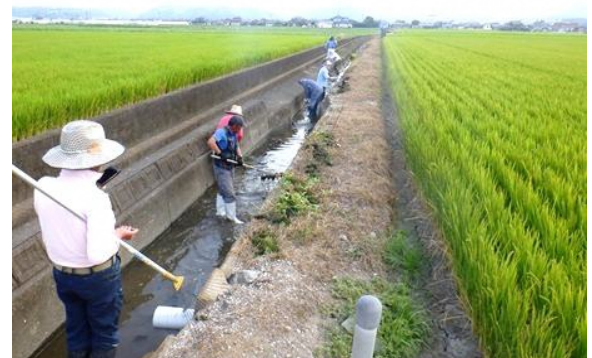
幹線水路 水路 泥上げ
