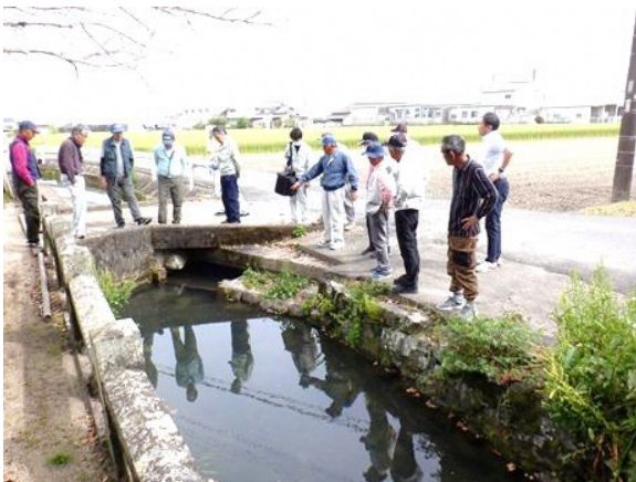
幹線水路 点検・機能診断
