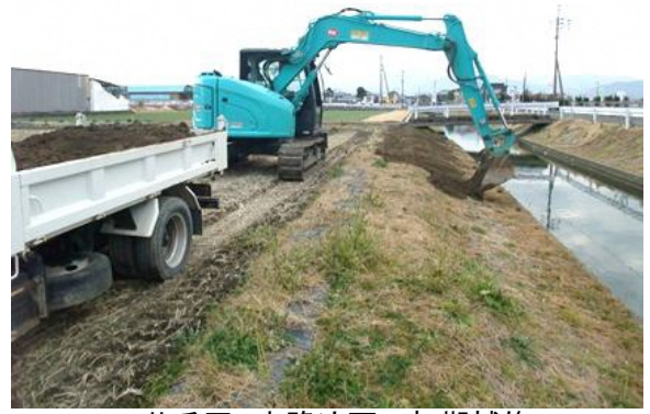
井手区 水路法面の初期補修
