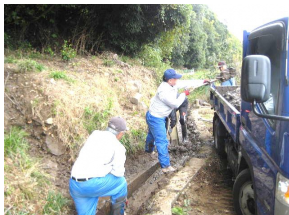
若殿分区 水路 泥上げ
