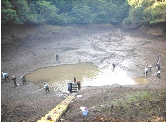
下浅浦区 ため池 泥上げ
