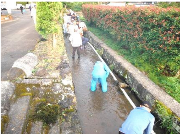
筒口区 水路 泥上げ
