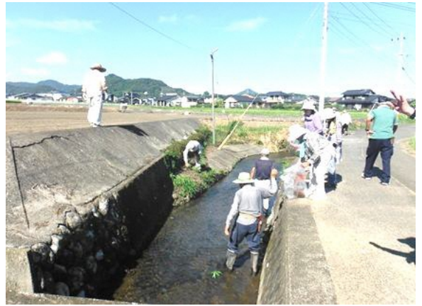
南川区 施設等の定期的な巡回点検・清掃
