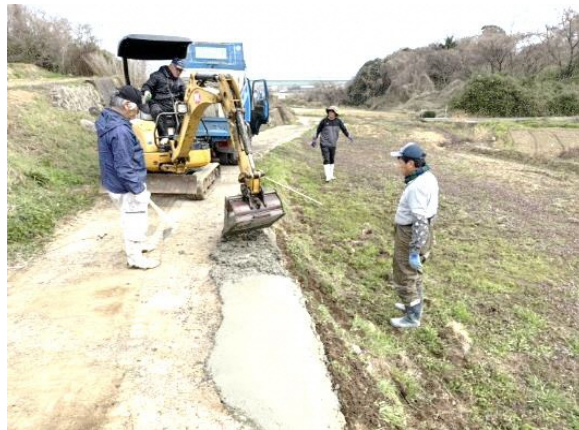
湯ノ峰区 破損施設の補修
