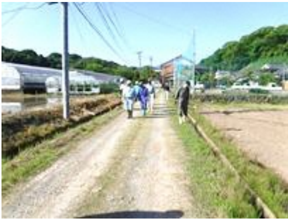
音成区 点検・機能診断
