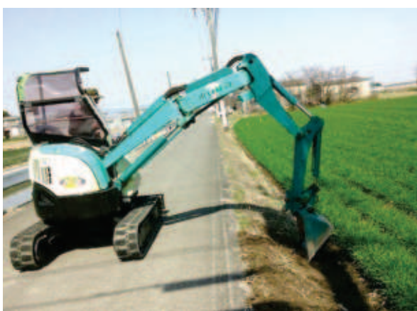
新籠区 法面の初期補修
