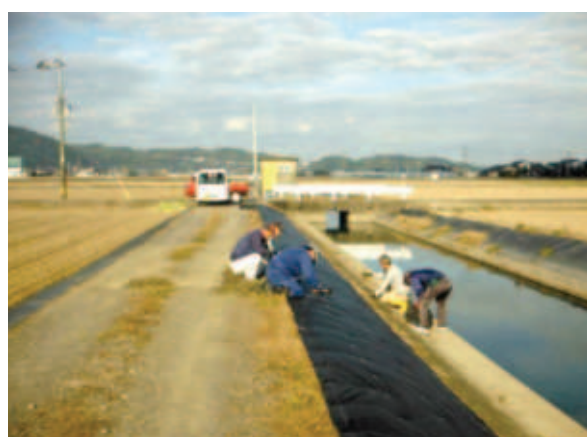
常広区 防草シート張り
