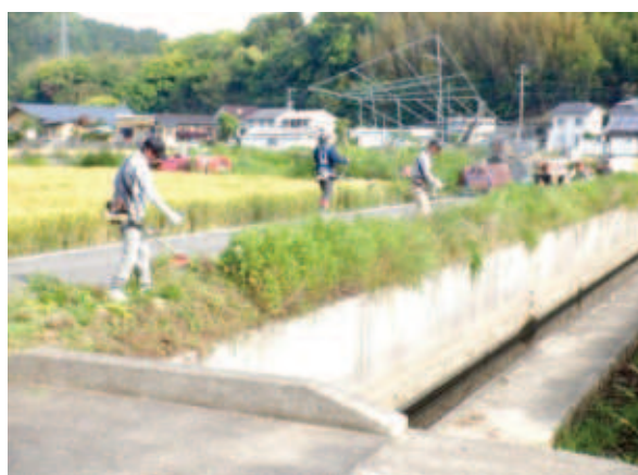
幹線水路 水路 草刈り
