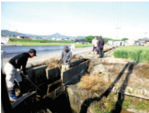
小舟津区 水路 泥上げ
