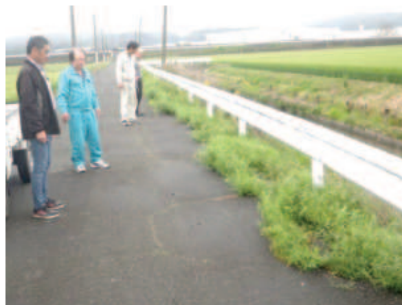
重ノ木区 点検・機能診断
