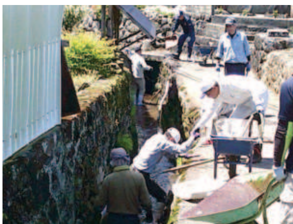
若殿分区 水路 泥上げ
