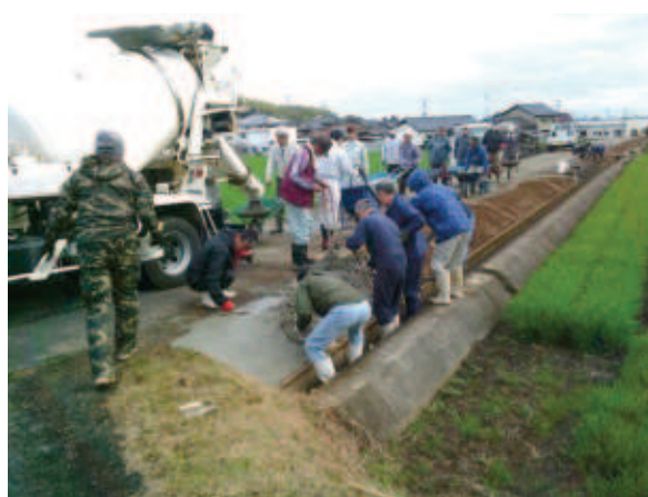
若殿分区 法面の補修
