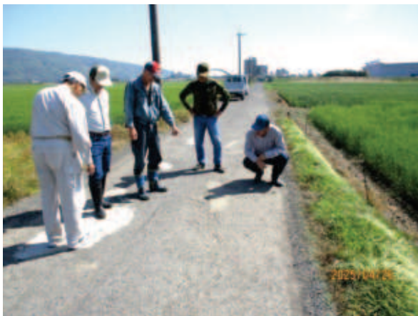
伏原区 点検・機能診断
