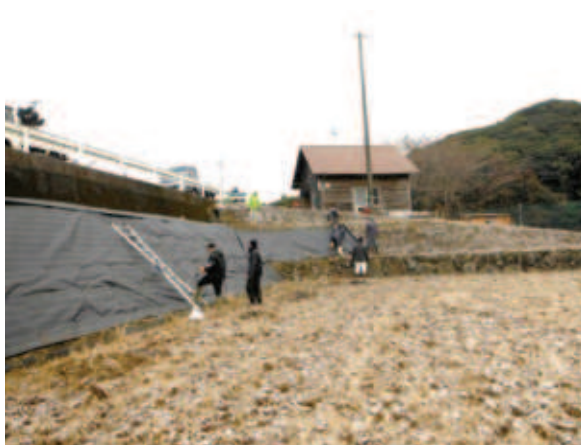
大野区 防草シート張り
