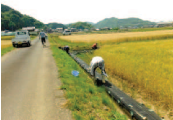
南川区 目地詰め
