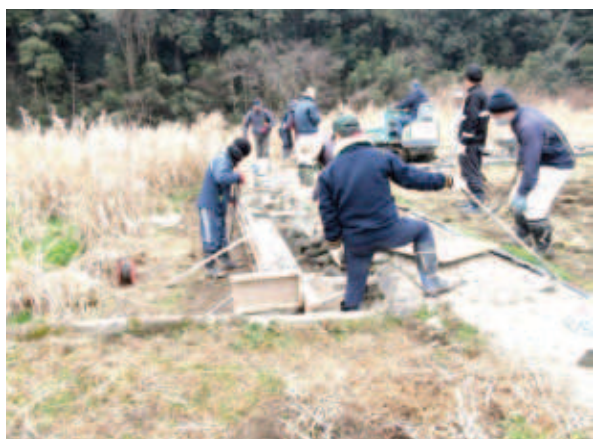
下古枝区 水路の破損部分の補修
