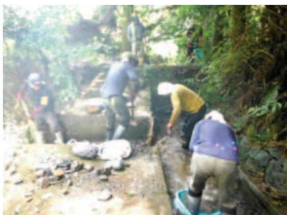
奥山区 異常気象後の応急措置
