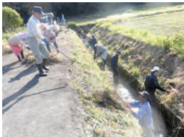
上古枝区 水路 泥上げ
