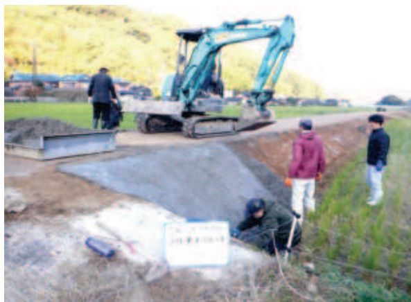
中尾区 法面の補修
