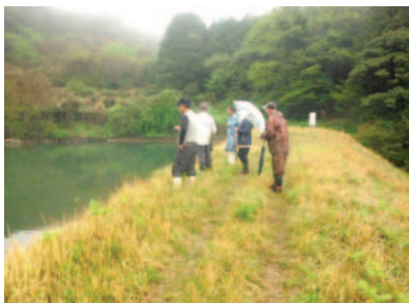
竹ノ木庭区 点検・機能診断
